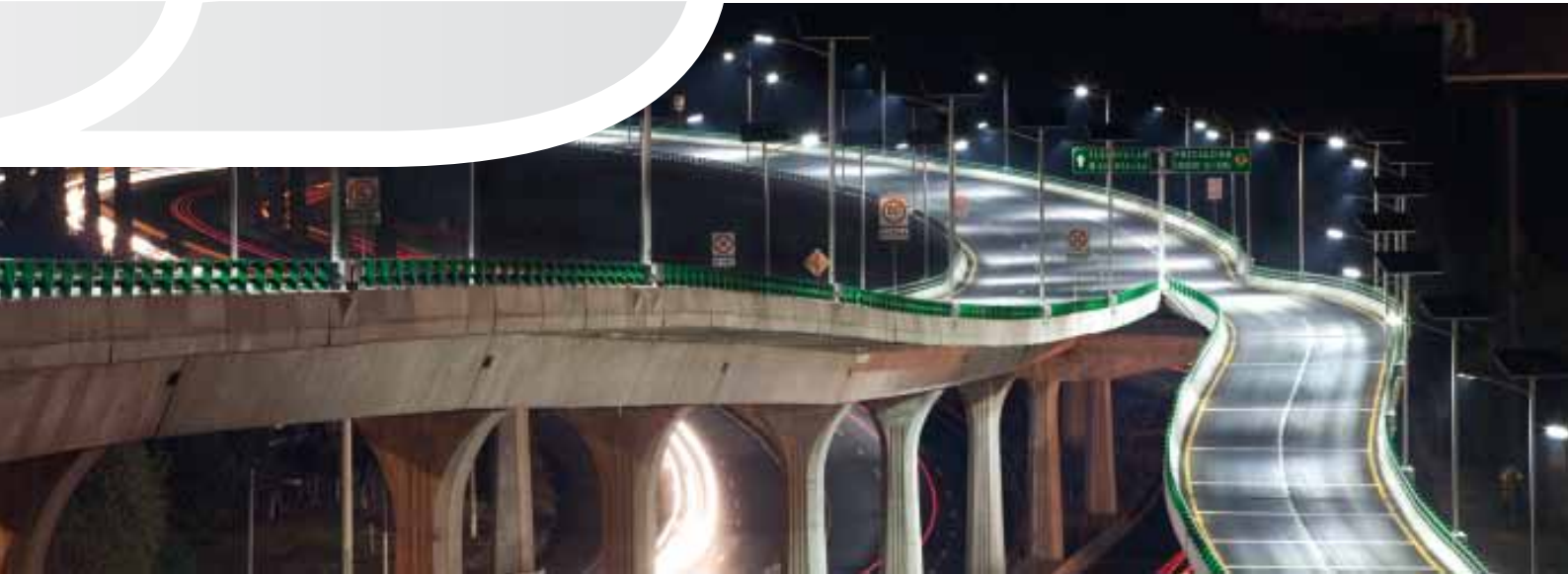
OHL - Viadotto bicentenario, Stato del Messico, Messico
