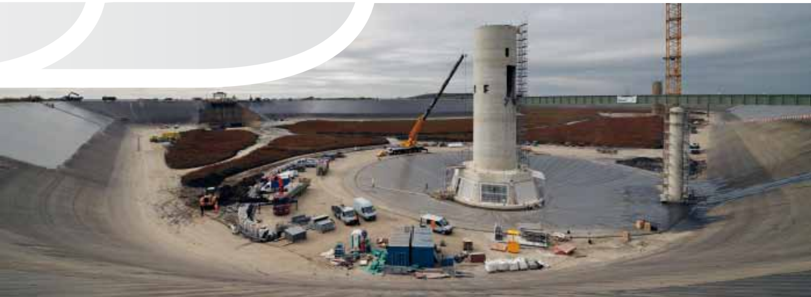
STRABAG - Cantiere della centrale di pompaggio idroelettrico di Vianden, Lussemburgo
